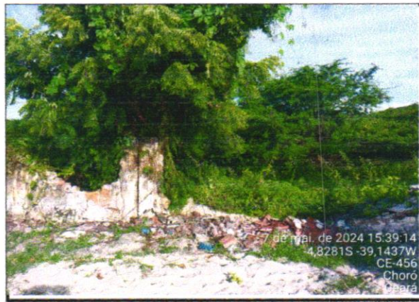
FOTO: MURO NO SENTIDO DO LADO SUL
